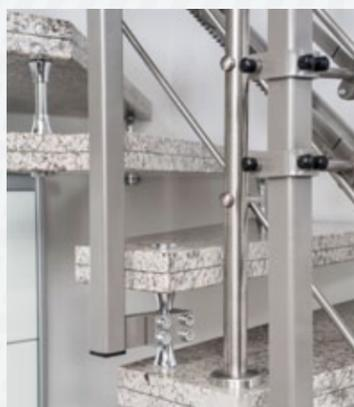
Befestigung an den Stufenbolzen
